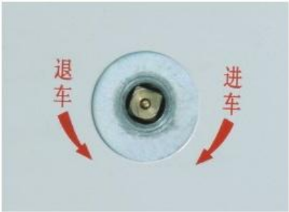
图3-13 断路器手车操作孔
