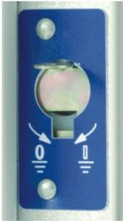
图3-14 接地开关操作孔及状态指示牌
