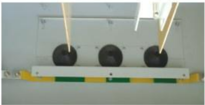
图2-12 电缆室接地系统
